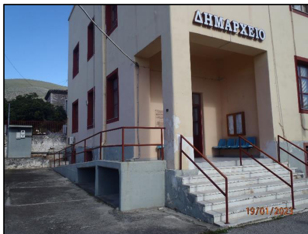
Εικόνα 14: Στυλίδα - Ράμπα πρόσβασης χωρίς στέγαστρο στο νέο κτίριο του δημαρχείου
