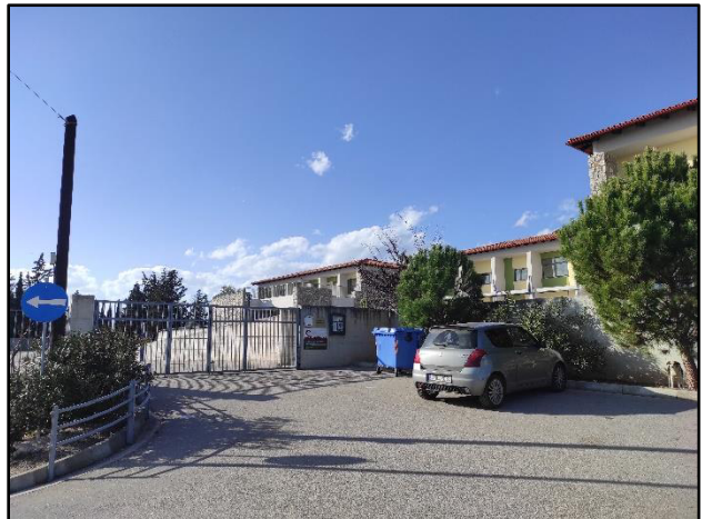
Εικόνα 12 Δημοτικό Σχολείο Αχινού.
