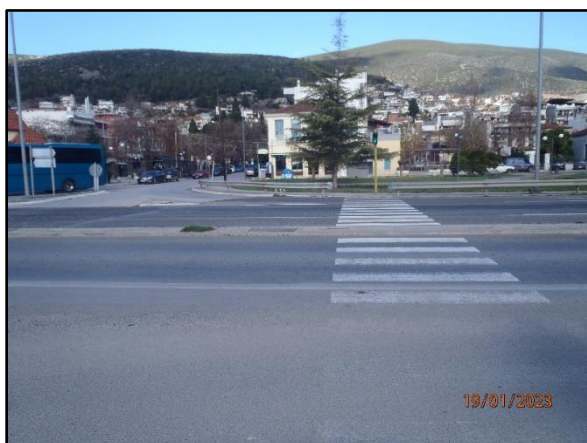
Εικόνα 4: Η διάβαση πεζών επί της παλαιάς εθνικής οδού στον οικισμό Στυλίδας είναι χωρίς ράμπα
